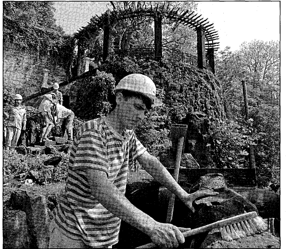
Um die denkmalgeschützte Gartenanlage am Weinberg wieder für die Öffentlichkeit zugänglich zu machen, wird zur Zeit in Zusammenarbeit mit der Handwerkskammer die Treppe instandgesetzt. (Foto: Fischer)
