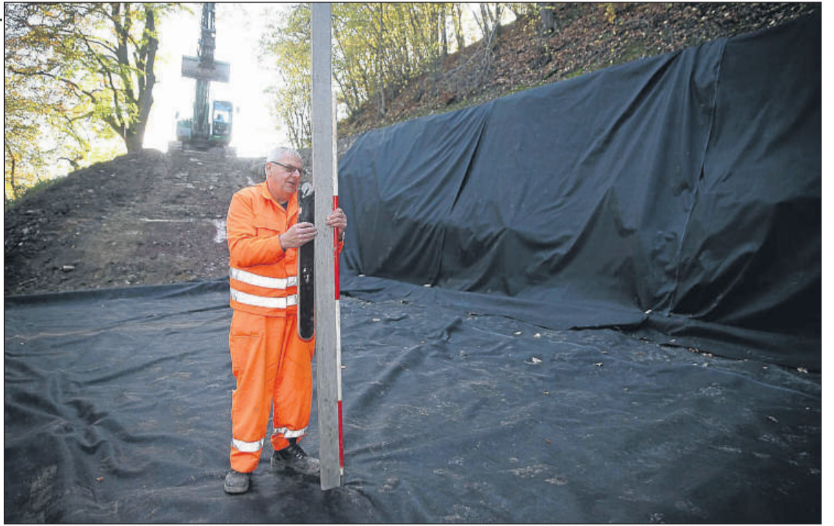
Tiefe Grube: Weil die Böschung abzurutschen drohte, wurde die Straße fast komplett bis auf standfesten Boden abgetragen. Baggerführer Gerhard Kloss steht für Kontrollmessungen in der fünf Meter tiefen Baugrube. Fotos: Thiele
