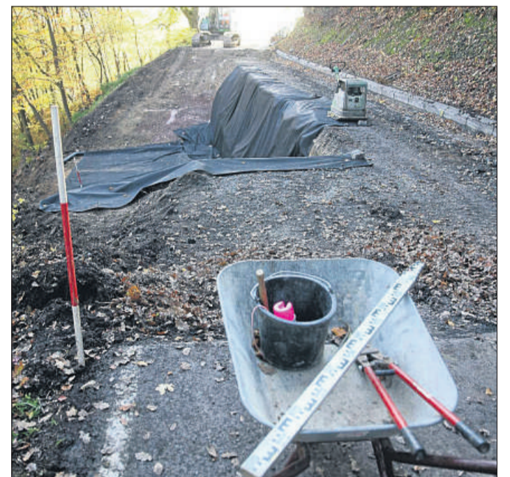
Ende der Straße: Autofahrer versuchten am Anfang noch, die Baustelle trotz Sperrung zu passieren. An dem Loch war dann Schluss.
