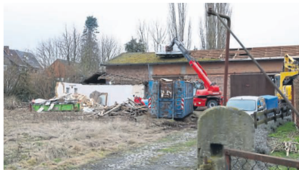
Wird abgebrochen: das Scheunengebäude auf dem Grundstück „Pferdewiese“ an der Ecke Kronen- und Grebenstraße in Harleshausen.
